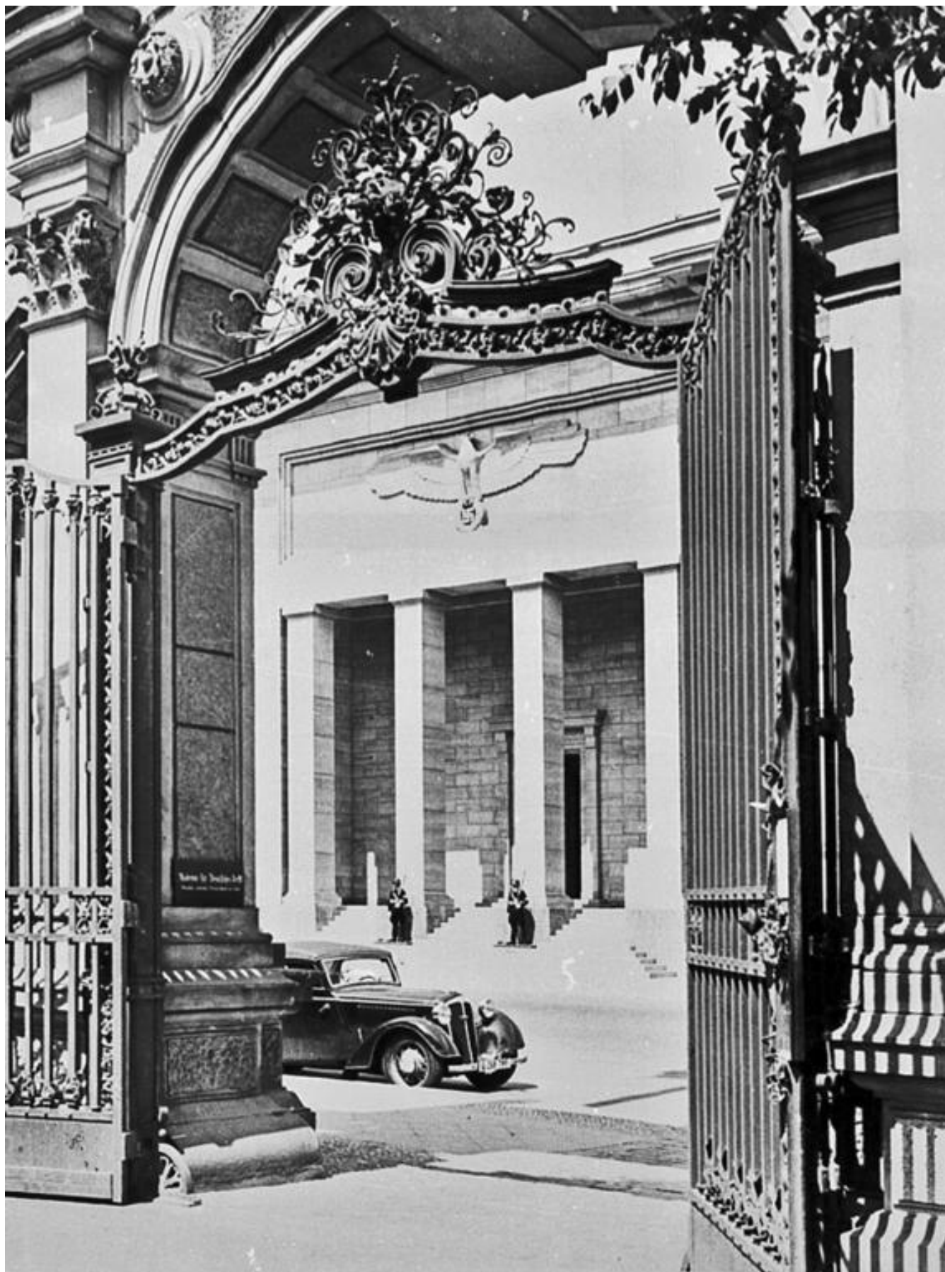
"LA NUEVA CANCELLERÍA", VISTA DESDE EL PATIO DE LA CASA DE LA VOSSTRASSE 22.
